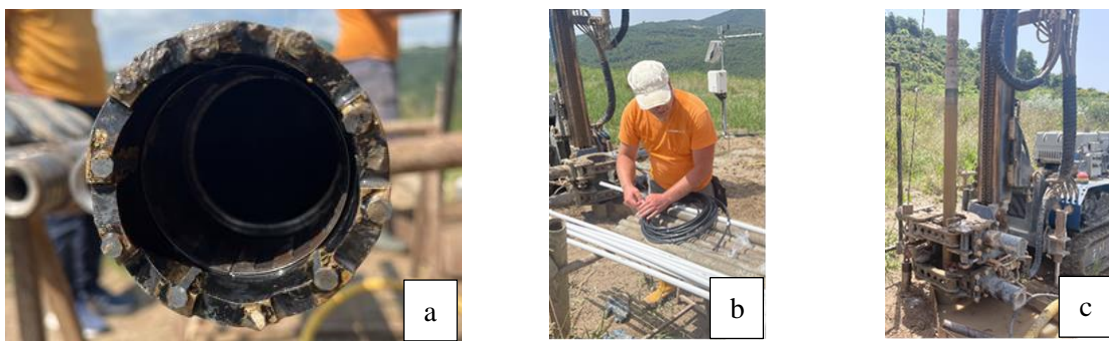
Fig 3. (a) Tubo carotiere di diametro d=66 mm; (b) installazione della catena termometrica sul tubo guida in PVC; (c) messa in opera delle camicie di rivestimento.
