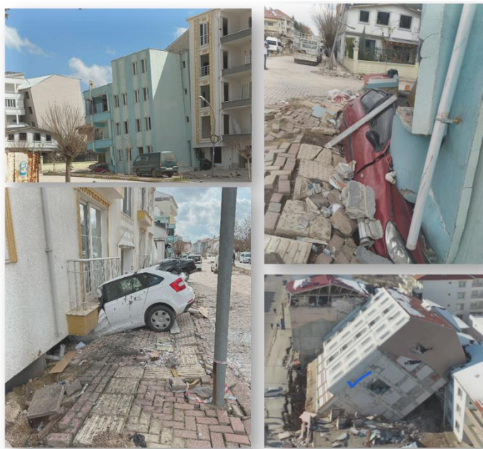
Fig 1 Esempi di danni dovuti alla liquefazione a Gölbaşı
